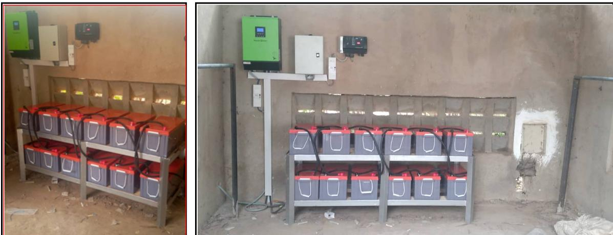
Système de Batteries pour le fonctionnement d'une pompe.
