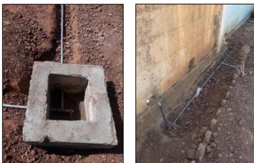
*Tuyauterie et regards de purge pour la conduite de biogaz.*
